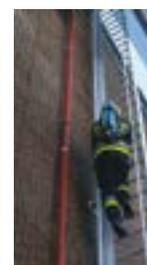
Refermée, cette échelle de secours déployable ressemble à une simple gouttière. Une fois ouverte, elle constitue un moyen d'évacuation en cas d'incendie ou un mode d'accès pour les sapeurs-pompiers.
